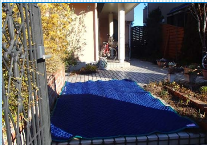
玄関前の養生風景
